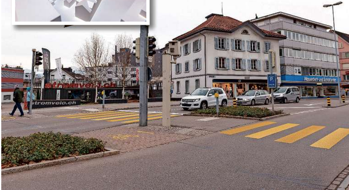
Vor Baustart: An dieser Ecke der Oberen Bahnhofstrasse entsteht eine markante neue Überbauung. Bild Pascal Büsser/Archiv
