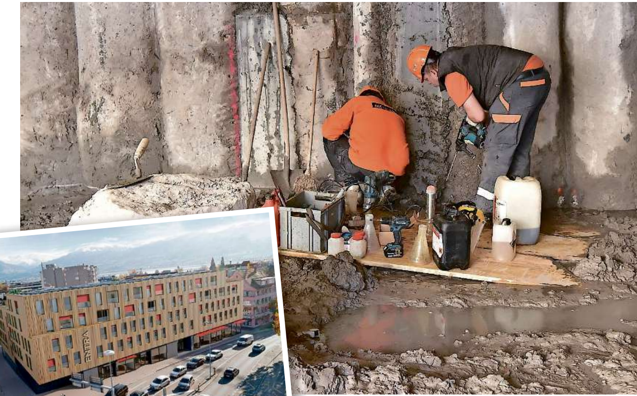
Arbeiten im Untergrund: Im Zentrum von Rapperswil schreitet das Bauprojekt Stadthof Süd voran. Bild Markus Timo Rüegg/Visualisierung zVg
